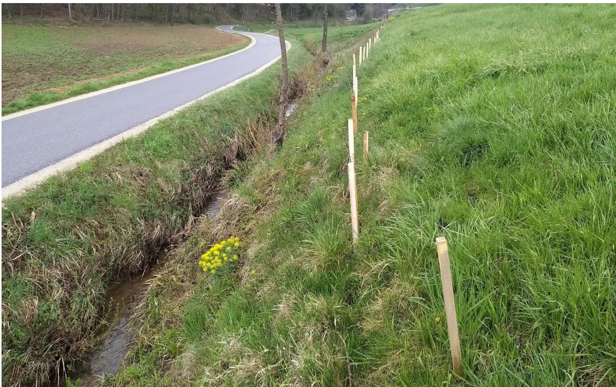
Vzpostavitev nove mejice na brežini nad vodotokom.
